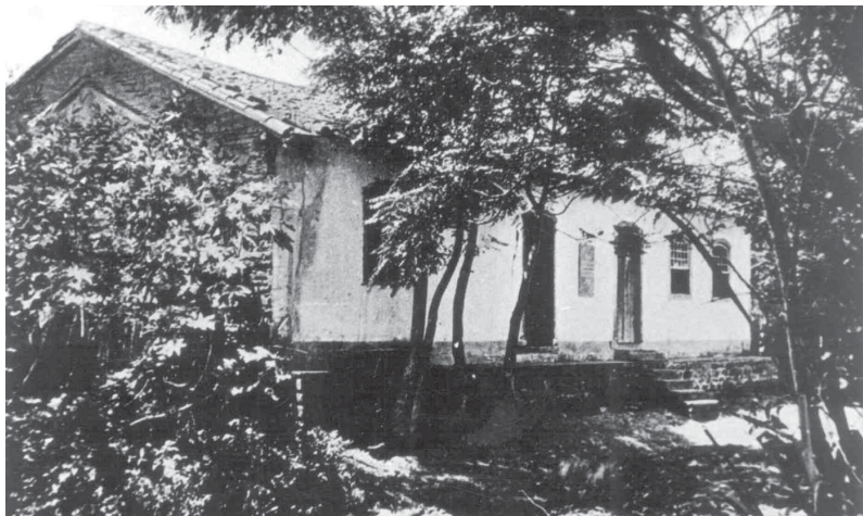
Antes da reforma da década de 1940 (MHVSL)
